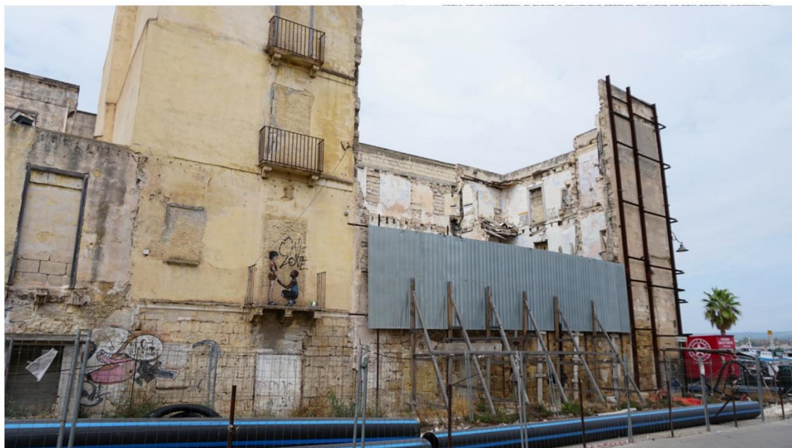
Fig. 4. Taranto, Vicolo Via Nuova. Demolizioni controllata per la rimozione dell'opera “One Love” di Stencil Noire.
